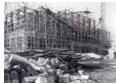
図書館工事風景
