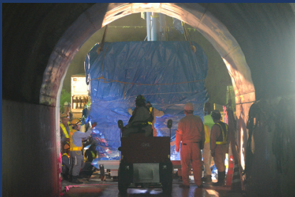
低温鏡用真空タンク搬入:低温鏡用真空タンクの最大部位搬入の作業風景。
