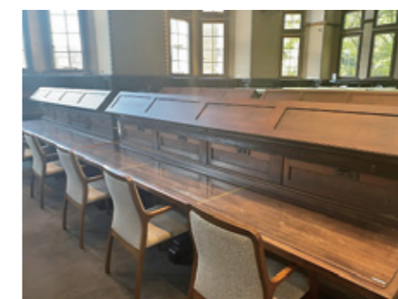
修復により見栄えも機能性も改善しました
